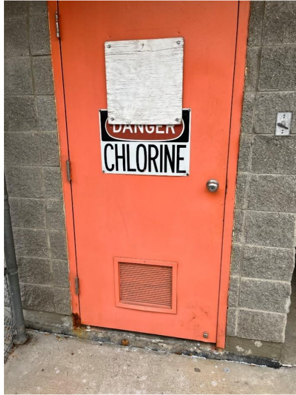
Plate 5 – Door Corrosion
